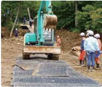
災害復旧現場
