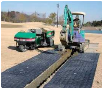
ゴルフ場整備
