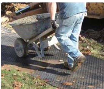
作業通路養生
