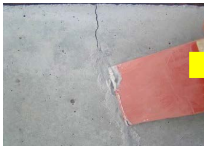
CSパテすり込み状況
