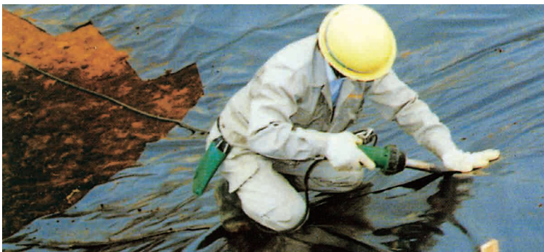
サンド遮水シート現場溶着
