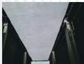
室外機下からの写真
