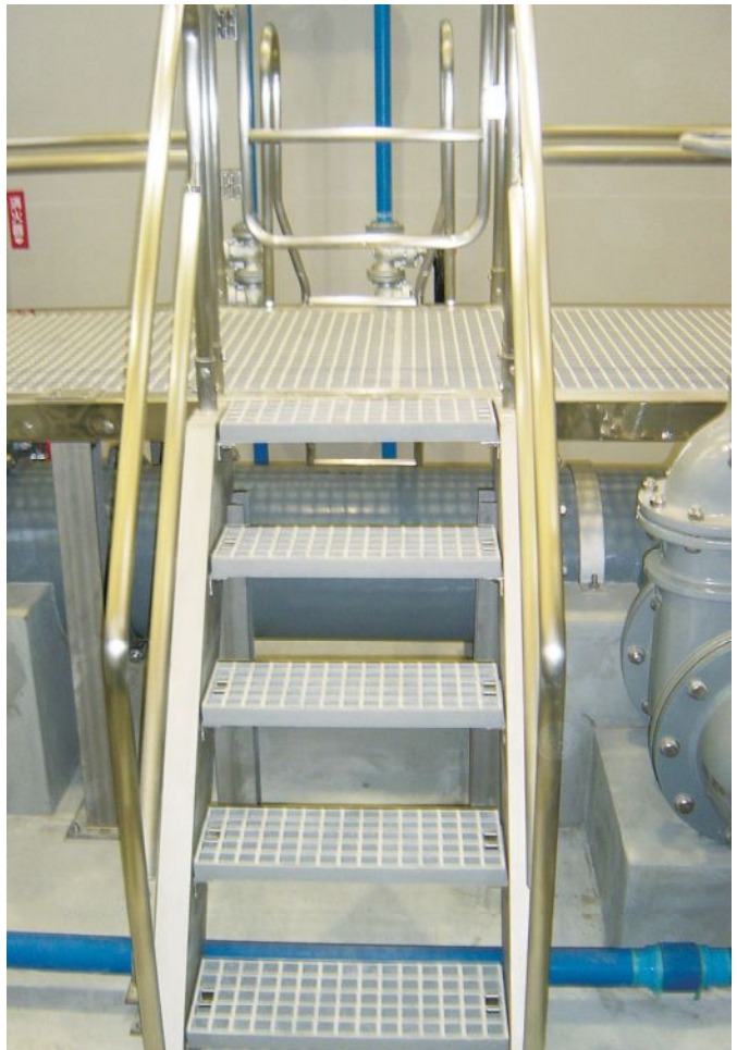
階段踏板施工例
