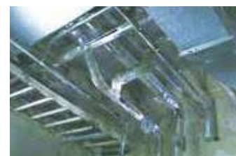
ダクト・配管の計測
