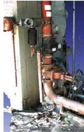
配管・バルブの計測
