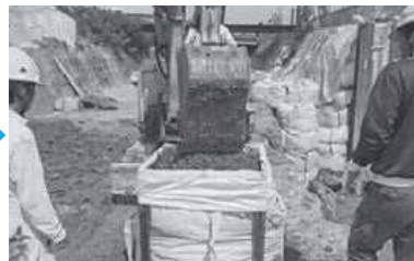
③土砂投入
