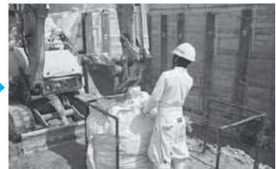
④スタンド取り外し・完成
