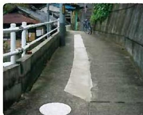
■ 歩道部段差補修
