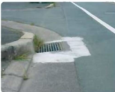
■ 集水桝復旧補修
