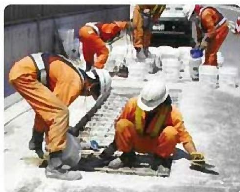
■ 中央自動車道松本管内維持修繕
