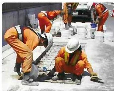
■ 中央自動車道松本管内維持修繕
