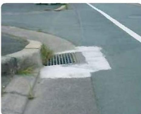
■ 集水枡復旧補修
