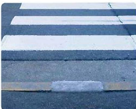
■ 歩車道ブロック補修
