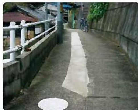
■ 歩道部段差補修
