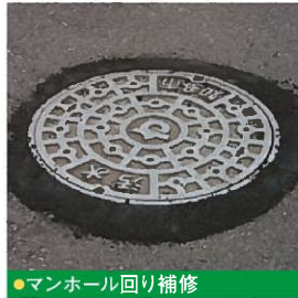
●マンホール回り補修
