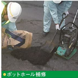
●ポットホール補修
