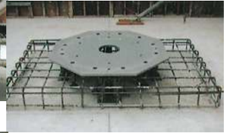
【写真12 下部オクトベース設置後】
