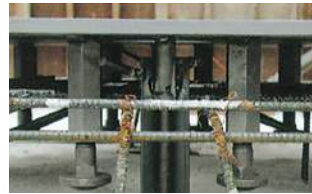
【写真11 溶接固定後】
