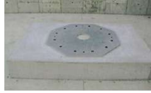
【写真13 コンクリート打設】
