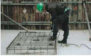
【写真3 アンカー孔挿孔】
