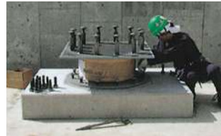
【写真17 ボルト仮締め】
