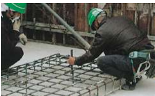
【写真5 アンカー打設】
