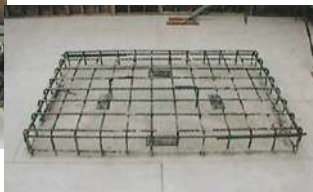
【写真6 レベルベース設置後】
