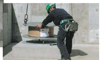
【写真14 積層ゴム据付け状況】
