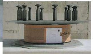
【写真16 上部オクトベース設置】
