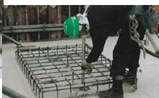
【写真4 アンカー孔掃除】
