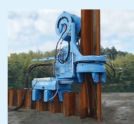
ハット形鋼矢板打設状況
