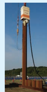
ハット形鋼矢板 打設状況
