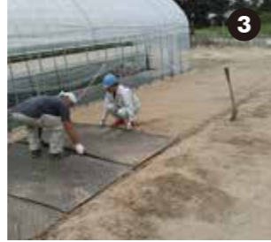
ボードを敷設する
