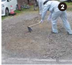
地面が平らになるよう敷き均す
