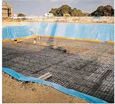
⑥端面部材 据付組立工
