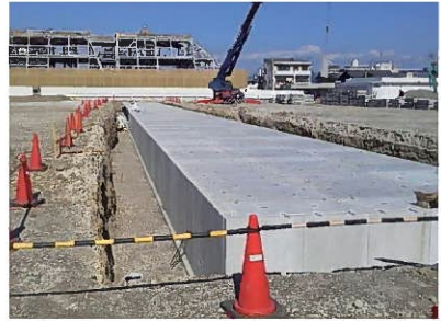
民間工事：岐阜県北方町
