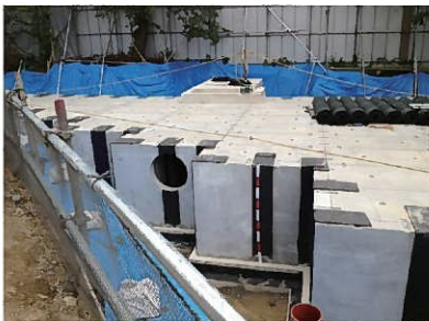
長岡京市役所：立命館中学校・高等学校
