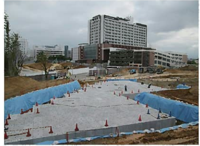
民間工事：愛知県長久手市
