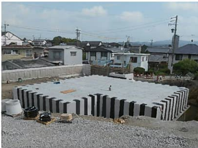
掛川市役所：中央消防署
