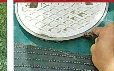
排水枡、水道枡の加工
