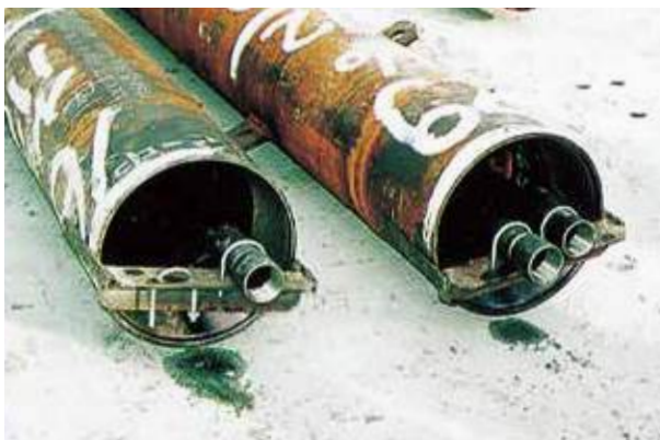
杭頭の金具で吊り下げる例
