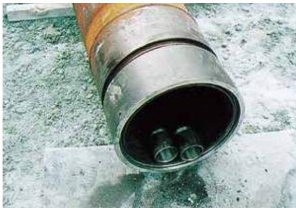
吊り込み用保護リングの取付状況
