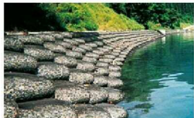
護岸の根固め工・洗掘防止 田沢湖 (秋田県)
