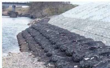
根固め工 雄物川 (秋田県)
