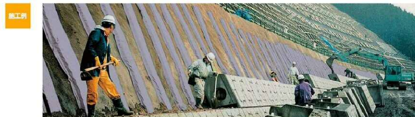
ブロック積み擁壁裏込排水
