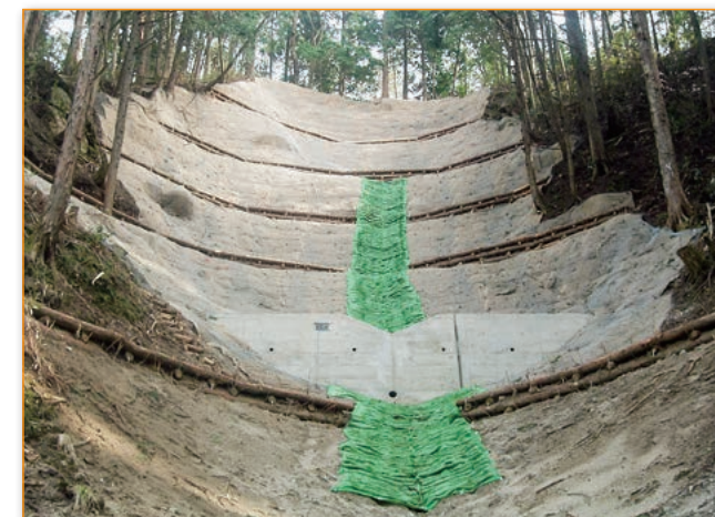
■ 愛知県豊田市 (2m 幅水路) 施工直後
