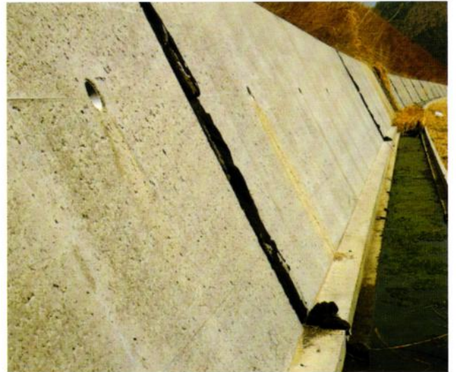
▲瀝青目地板を使用(はみ出し箇所)
