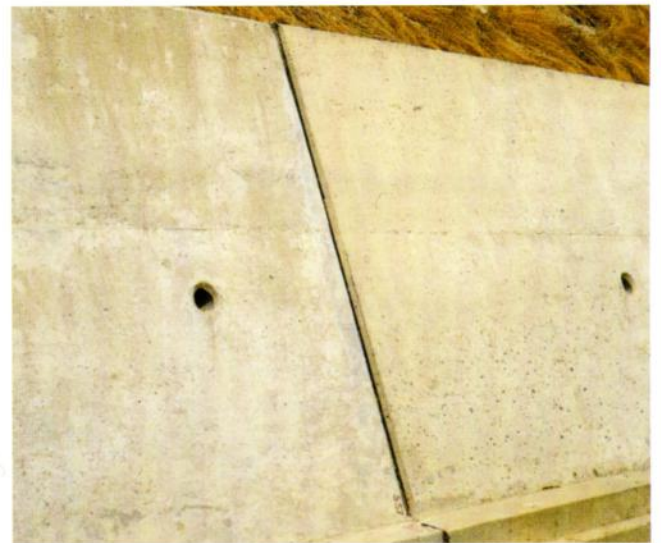
▲フジスーパータイトを使用(はみ出しがない)
