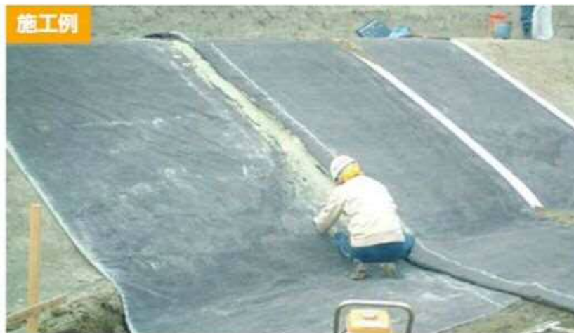
水辺景観工事
