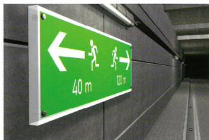
例：トンネル内における非常口避難誘導表示の取付け
