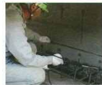
打継部処理CS-21散布状況
