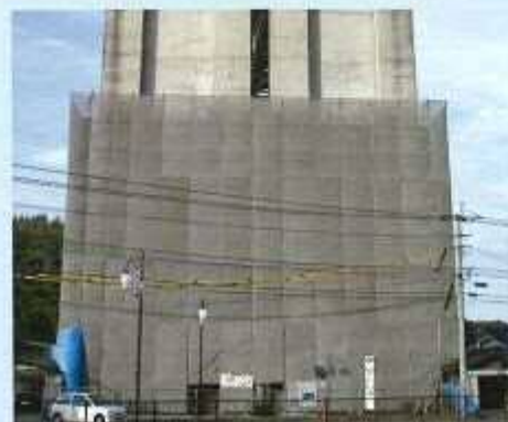
橋脚表面保護
