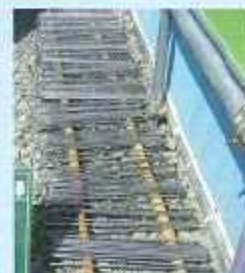
セパレータCS-21塗布後促進養生状況
