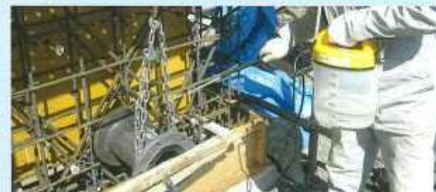
配管部処理CS-21散布状況
