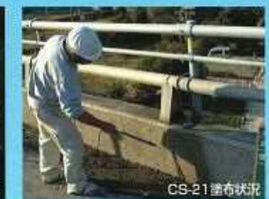
CS-21塗布状況
