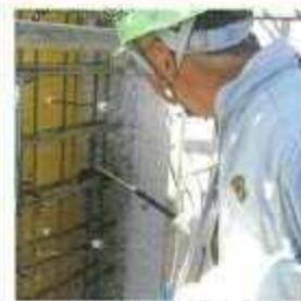
打継部処理CS-21散布状況
