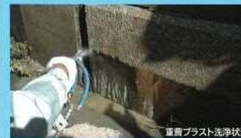
重曹プラスト洗浄状況
