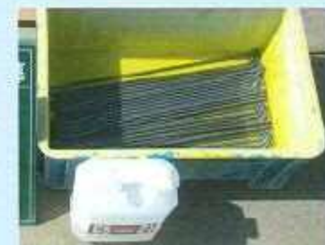
セパレータCS-21塗布(どぶ漬け)状況
