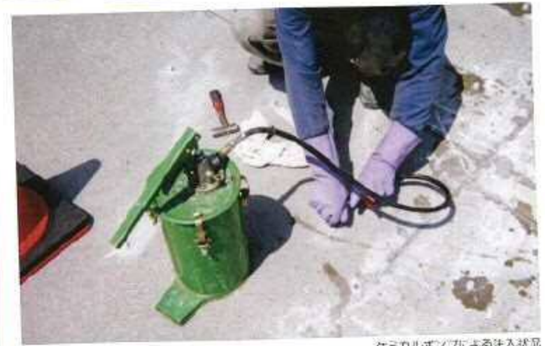
ケミカルポンプによる注入状況
