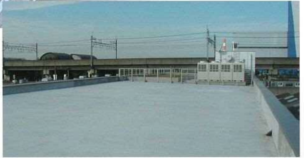
ビル屋上床版
