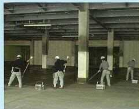
CS-21 塗布状況
