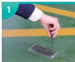
1 サポートベースの蓋をプラス ドライバーで外します。
