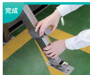
完成 サポートの長さを調整し ボルト固定します。
