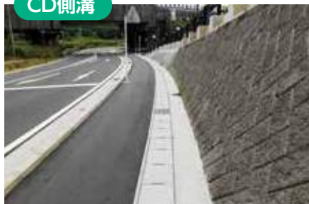
袋井土木事務所 吉沢金谷線 菊川市
