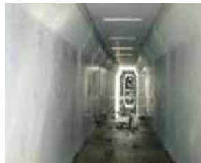
インバートコンクリート打設
