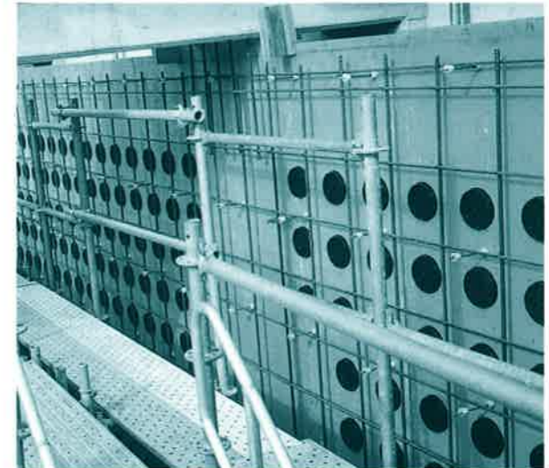
型枠にスリーブメイトX型を、釘1本で取りつけたところ。
