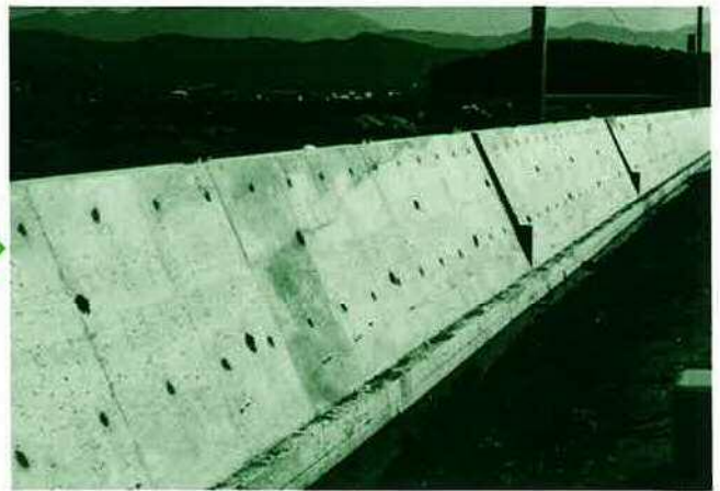
宅地造成工事のブロック積み擁壁
