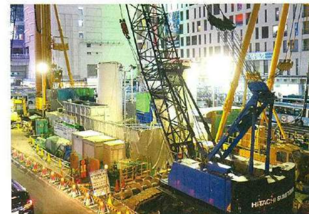
5 | 工事現場の照明や騒音計・騒音表示カメラ
