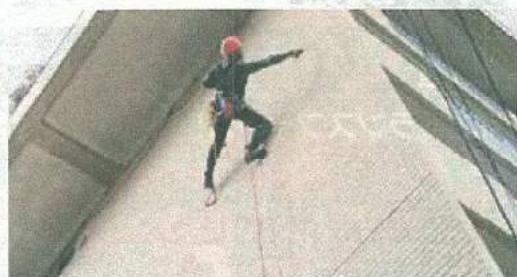
ロープアクセスによるコンクリート壁のタイル浮き点検
