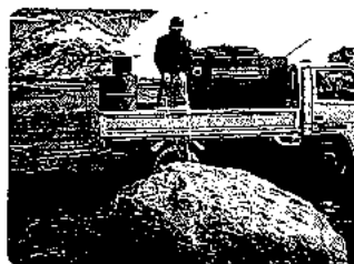
注水作業 注水分配器・注水チューブをご使用下さい。 ヘッド差利用/ポンプ使用
