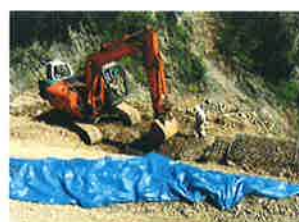
詰石(現地発生材)
